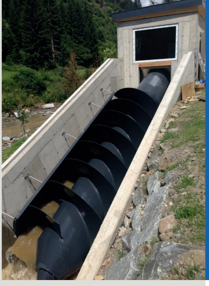
Die Wasserkraftschnecke bringt mit der Nettofallhöhe von 2,5 m bei der Ausbauwassermenge von 2,5 m³/s eine Engpassleistung von ca. 45 kW und erzeugt im Regeljahr ein Regelarbeitsvermögen von ca. 235.000 kWh. Ca. 93.000 kWh/a oder ca. 90 % des Stromverbrauches werden direkt in der Kläranlage verbraucht. Der Rest wird in das Stromnetz eingespeist.
